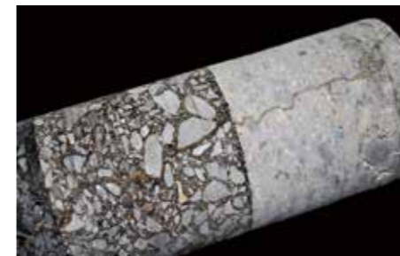
裂缝焊接施工取芯效果
