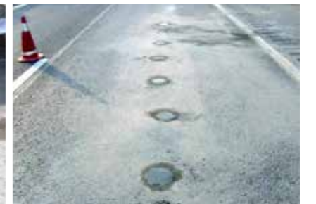
CGMT 路基非开挖快速加固施工效果
